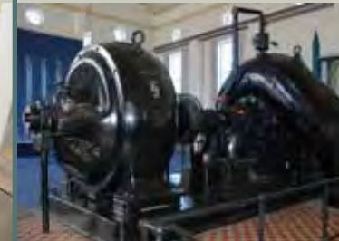
3 Abwasserpumpen von 1915
